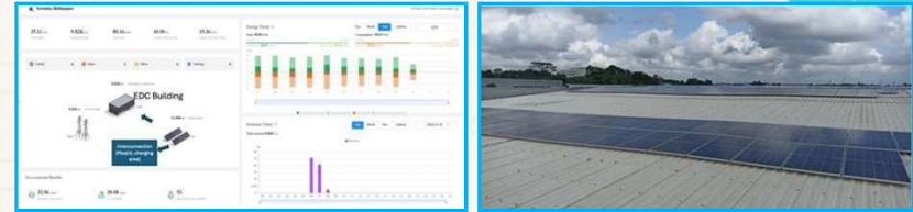
Pemakaian interconnection energi solar panel
